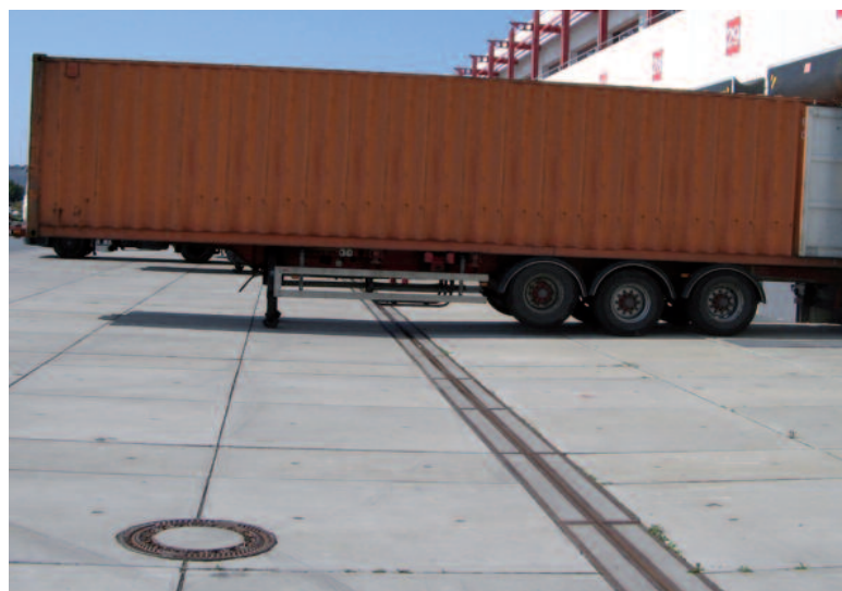
Nawierzchnie przed rampami załadunkowymi
