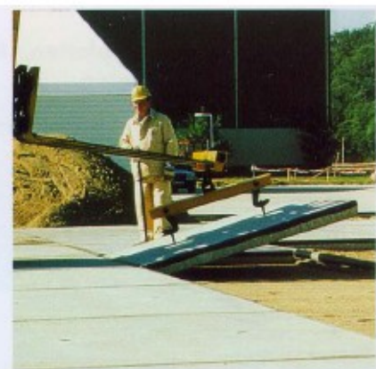
Układanie płyt za pomocą trawersy i specjalnych kluczy (dla płyt z otworami)
