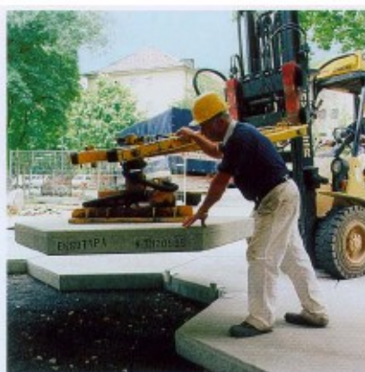
Układanie płyt za pomocą wózka widłowego z zainstalowanym chwytakiem próżniowym.
